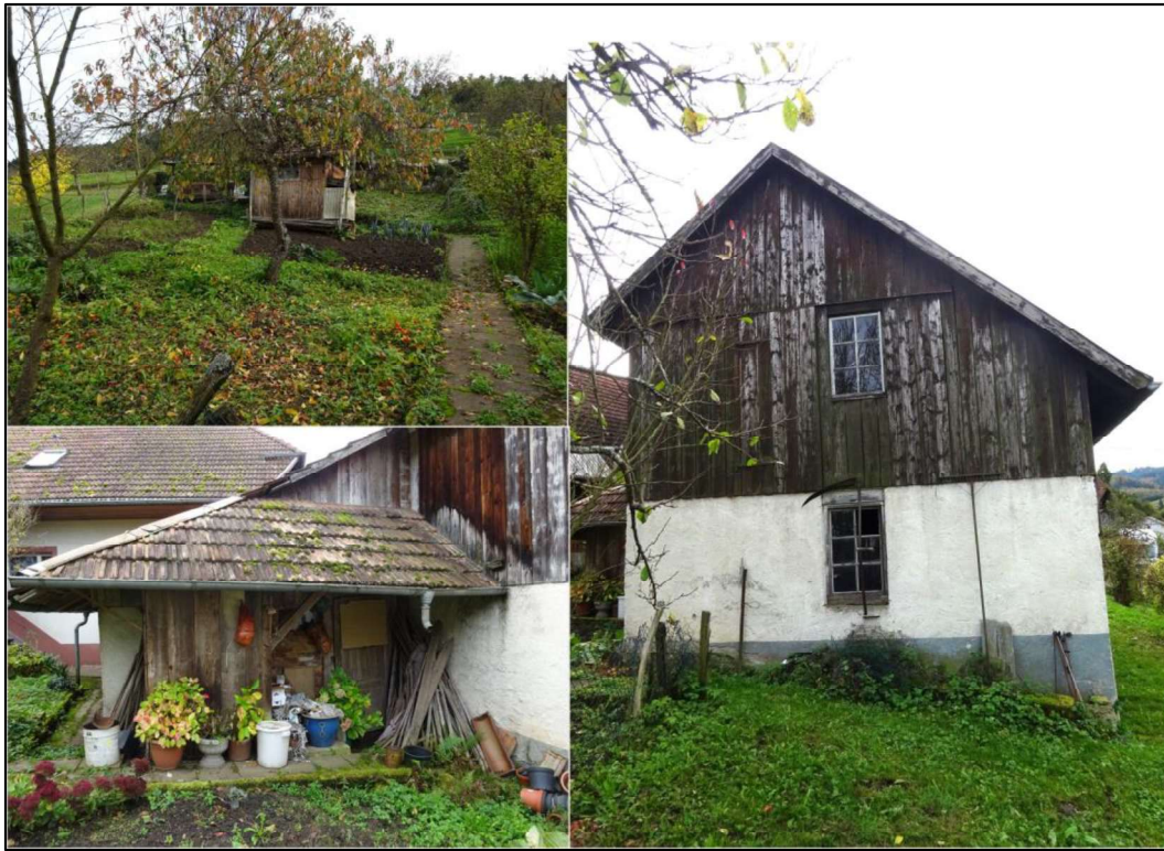
Abb. 2: Schuppen (rechts und unten links) und Nutzgarten (oben links), die durch das Bauvorhaben anteilig überplant werden. Der Schuppen wird in diesem Zuge abgerissen.
