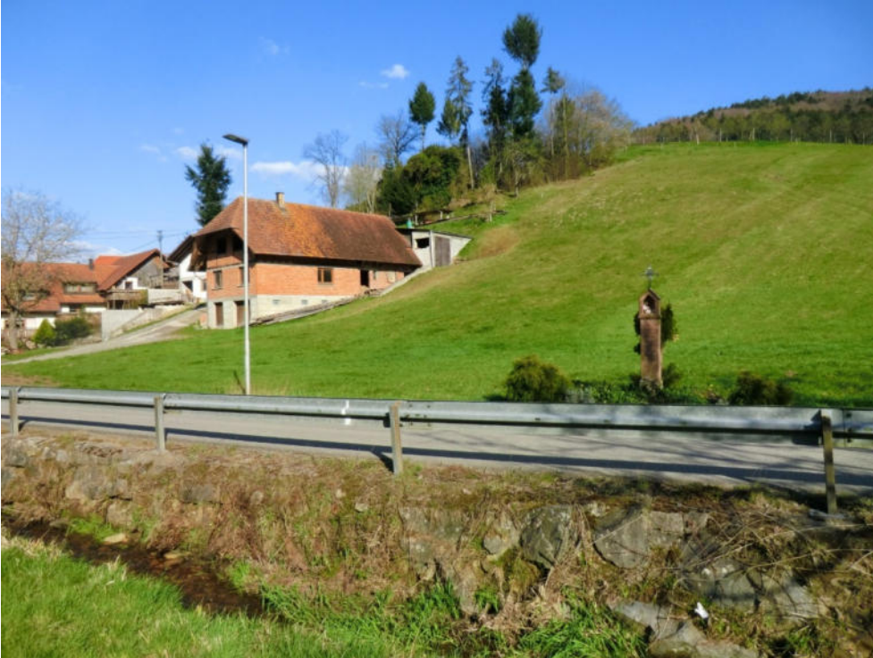
Abb. Blick auf das Planungsgebiet
