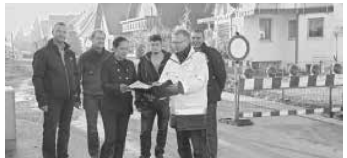
Ortsbegehung an Biberachs Großbaustelle in der Straße »Am Sportplatz« (von links): Dirk Weise, Leiter der Technischen Betriebe, Bauleiter Christian Deusch / Firma Knäble, Bürgermeisterin Daniela Paletta, Nicolas Knäble / Firma Knäble, Arno Lindner von der LBBW Kommunalentwicklung und Volker Haag / Büro Zink-Ingenieure.
