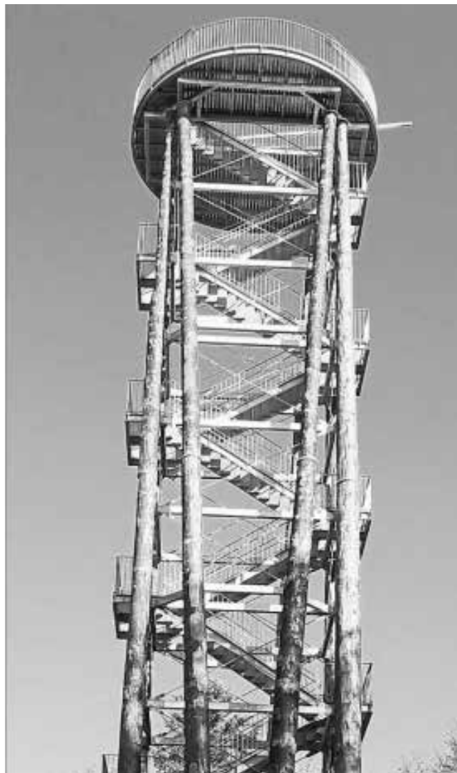
Der neue Aussichtsturm auf dem Urenkopf in Haslach ist auf vier Zugangswegen zu Fuß zu erreichen, die vom Schwarzwaldverein Haslach ausgezeichnet wurden. Der von den wwg-architekten, Biberach geplante Turm in Holz-/Stahlkonstruktion hat folgende Abmessungen: Höhe der Plattform über Gelände: 32,95 Meter; Gesamthöhe des Turms: 34,05 Meter; Gesamthöhe inklusiv Fahnenmast: rund 40 Meter; Vollgeschosse: Zwölf; Treppenstufen: 183; Größe der Aussichtsplattform: 43 Quadratmeter.
