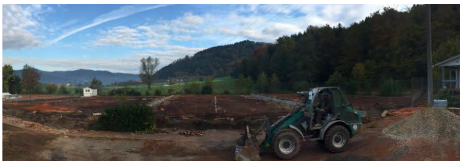
Platzsanierung von Oktober 2017 bis April 2018
