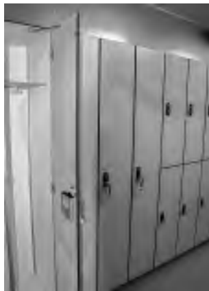
Neue Spinde in der Damen-Umkleide – die großen verfügen über eine Schließanlage.
