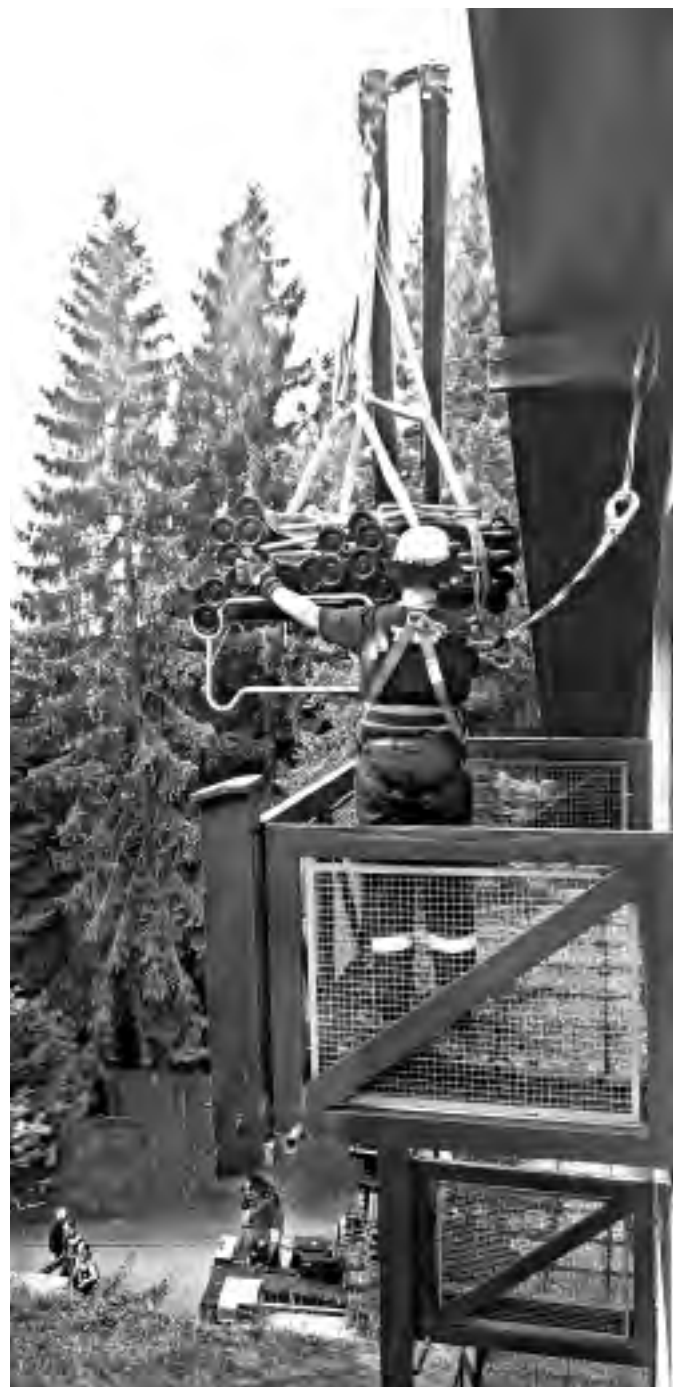
Mit schwerem Gerät wurden die Betten in das Gebäude gebracht.
