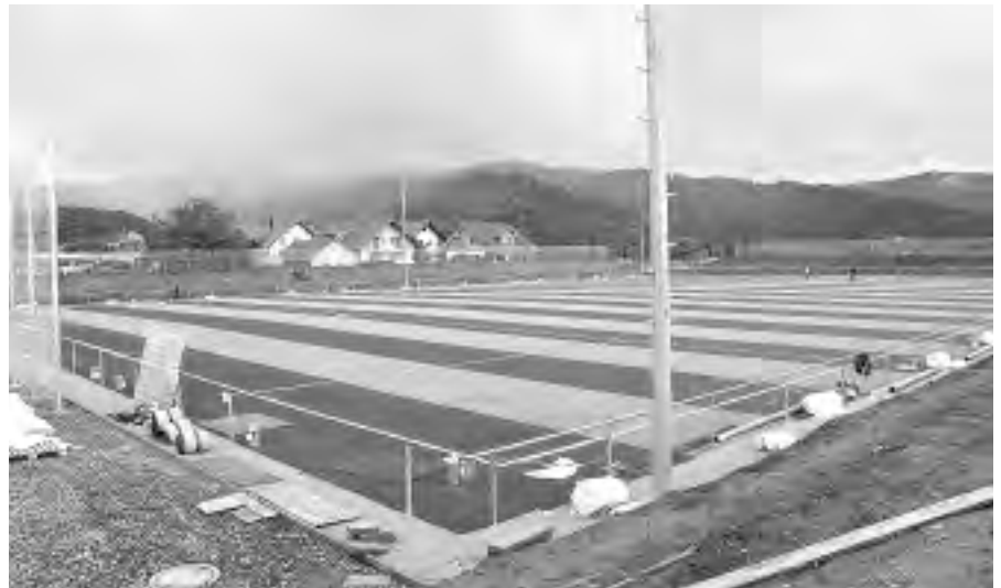
Bereits in einer Woche könnte der Ball hier schon rollen – der Kunstrasenplatz ist kurz vor der Fertigstellung. Fotos: Andrea Bohner (3)
