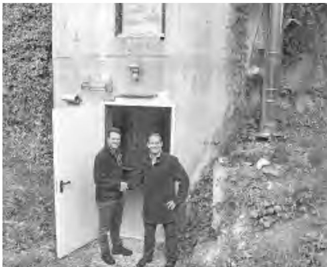
Simon Christ (links), Betreiber der Hackschnitzelanlage, und Markus Schäfer, 1. Vorsitzender der DJK Prinzbach, vor dem Silo, in dem die Hackschnitzelanlage eingebaut ist. Die Idee eines »Wärmeverbunds« bei der Heizungssanierung entstand 2013, als die Heizungsanlage von Simon Christ nahezu zeitgleich defekt war wie die Heizungsanlage der DJK Prinzbach. Beide Parteien haben einen Wärmeliefervertrag abgeschlossen.
