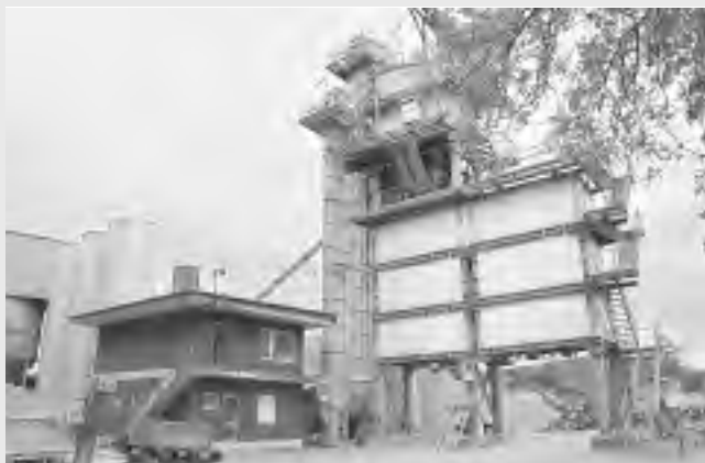
Die Asphaltmischanlage der Firma Knäble: Betriebsbedürfnisse und Belange des Naturschutzes sind im Gewerbegebiet »Reberg« gut in Einklang zu bringen. Foto: Andrea Bohner
