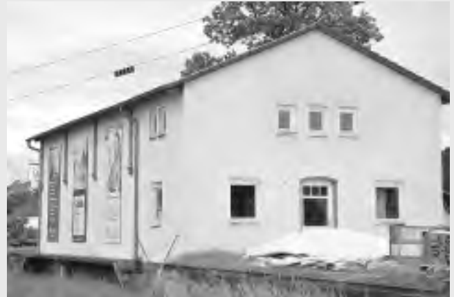
Die alte Güterhalle soll umgebaut werden und künftig 65 Quadratmeter Wohnraum für die Unterbringung von Flüchtlingen bieten.
