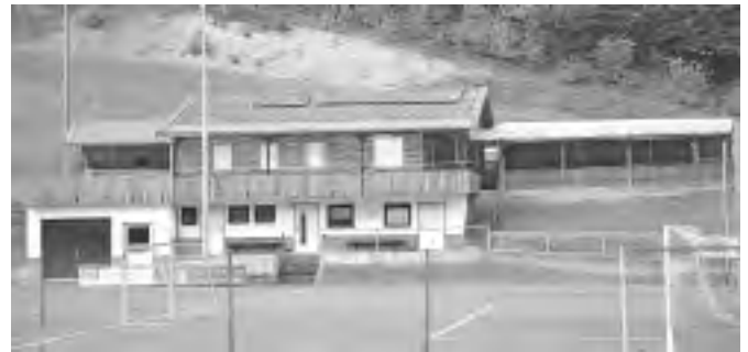
Auf dem Dach des Vereinsgebäudes hat die DJK Prinzbach zwei weitere Solarmodule installiert, um die Leistung der Anlage zu erhöhen.
