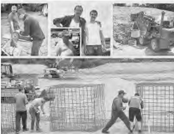
Die Fotos zeigen (oben, von links) wie die Stahlrohre für die Umrandung zugeschnitten wurden; daneben die Verantwortlichen für die richtige Betonmischung Piet Werner und Dominik Schwendemann (von links) sowie Martin Leopold; den Einsatz der von der Familie Schwendemann zur Verfügung gestellten Geräte sowie (unten) wie AH und Aktive die Baustahlkörbe für die Flutlichtmast-Sockel richteten.
